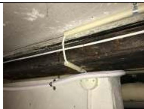
Kreativ fremføring af tilledninger i plastrør. Tilledningen sidder også i klemme under røret.
