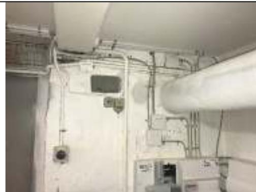
Installationer i kælderen, gamle fittingsinstallationer med stofisolerede ledninger.
