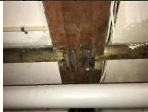
Løse forsyningsledninger ført under rør.
