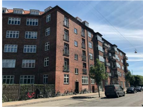
Facade, P. G. Ramms Allé
