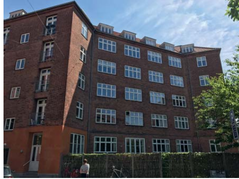
Facade, P. G. Ramms Allé
